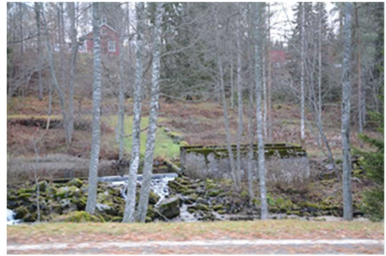
KUVA 20: Sahan perustuksia ja tieuria ennen sillan tekemistä v. 2014. [ J-P]
