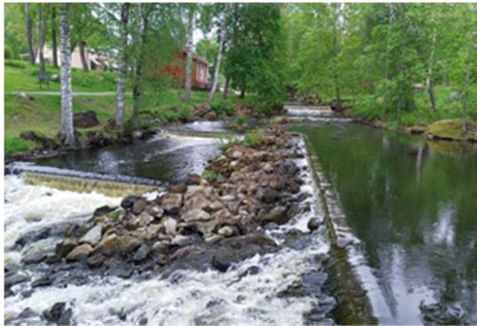
KUVA 19: Koskiuomaa patorakenteineen v. 2020.[JH]
