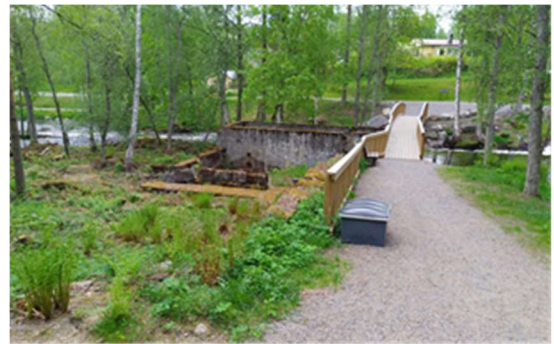
KUVA 22: Sillalle johtava kulkuväylän pohja on sahan aikuinen. Vertaa kuvaan yllä. [JH] 2020
